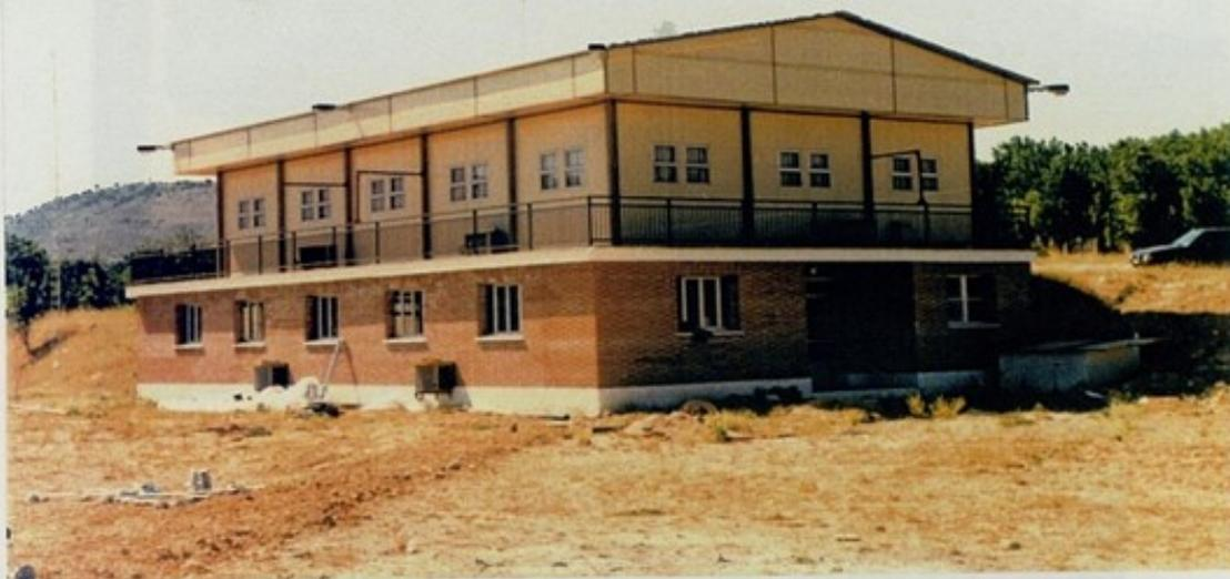
Barracón TYCE-11 montado sobre obra de fábrica en los terrenos del TYCE.
