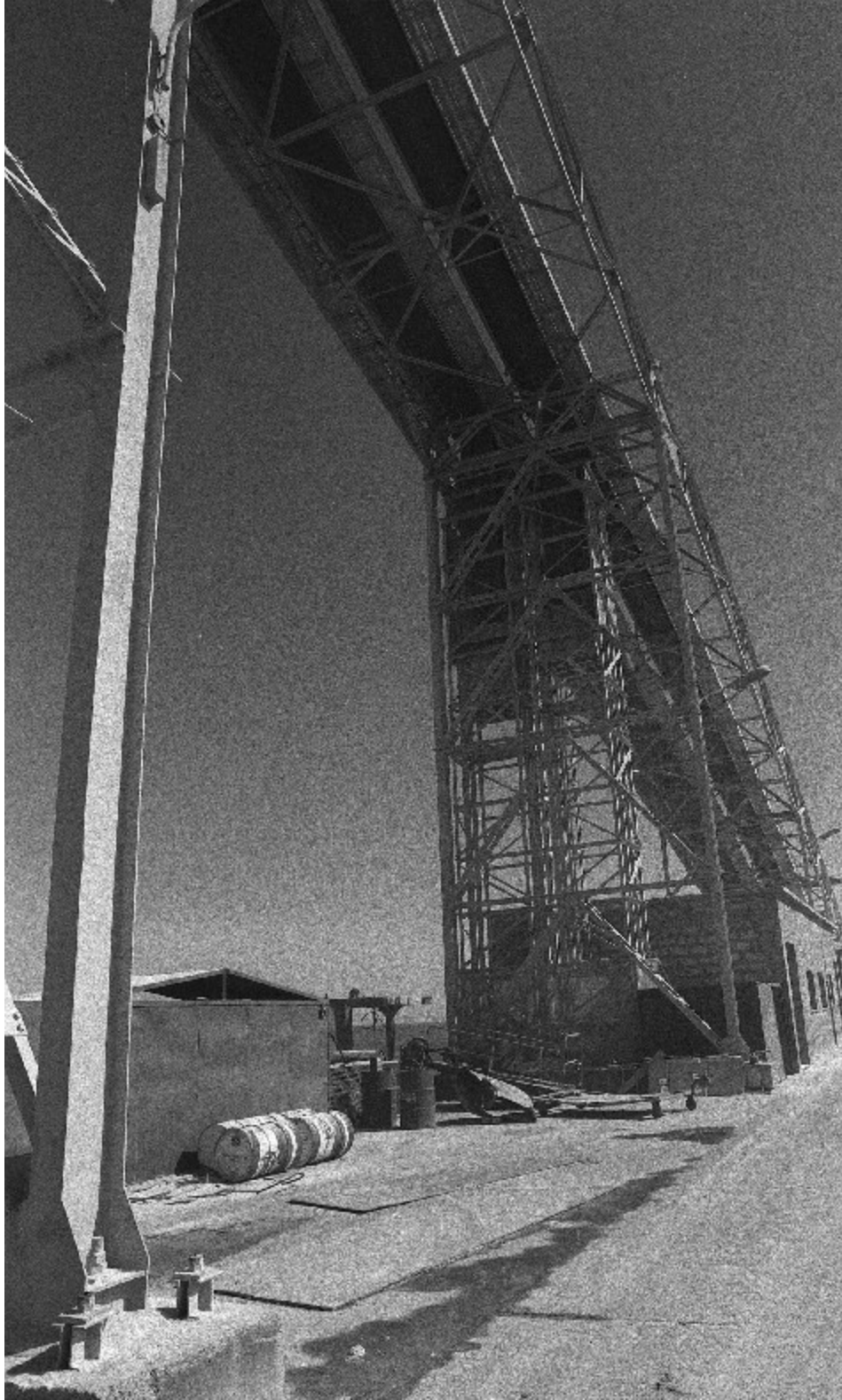
La cinta transportadora de fosfatos fue incendiada por el Frente Polisario. El sabotaje paralizó la extracción de mineral.
