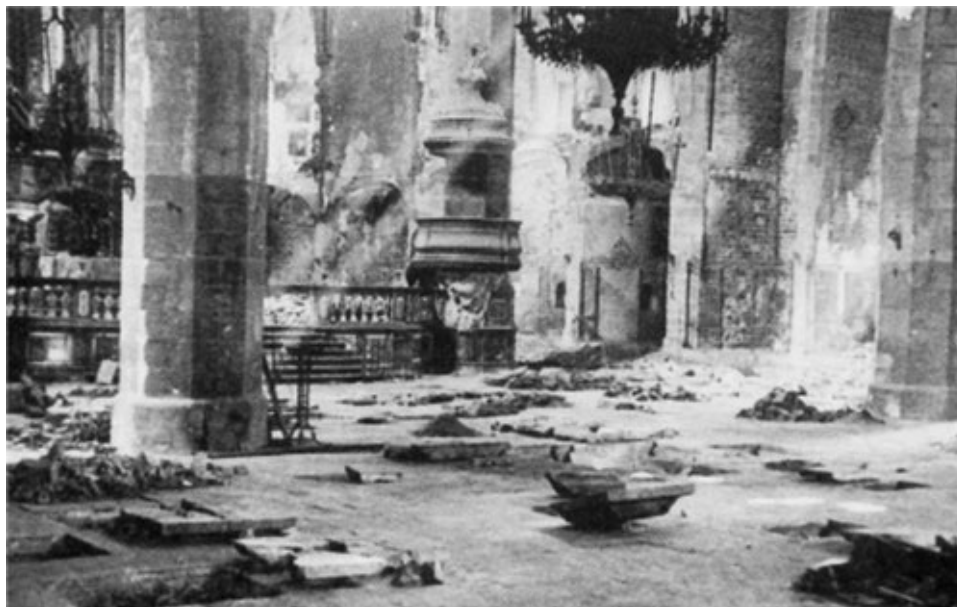
Nave central de la iglesia Santa María del Mar, incendiada, con posterior saqueo y violación de tumbas (Barcelona).
