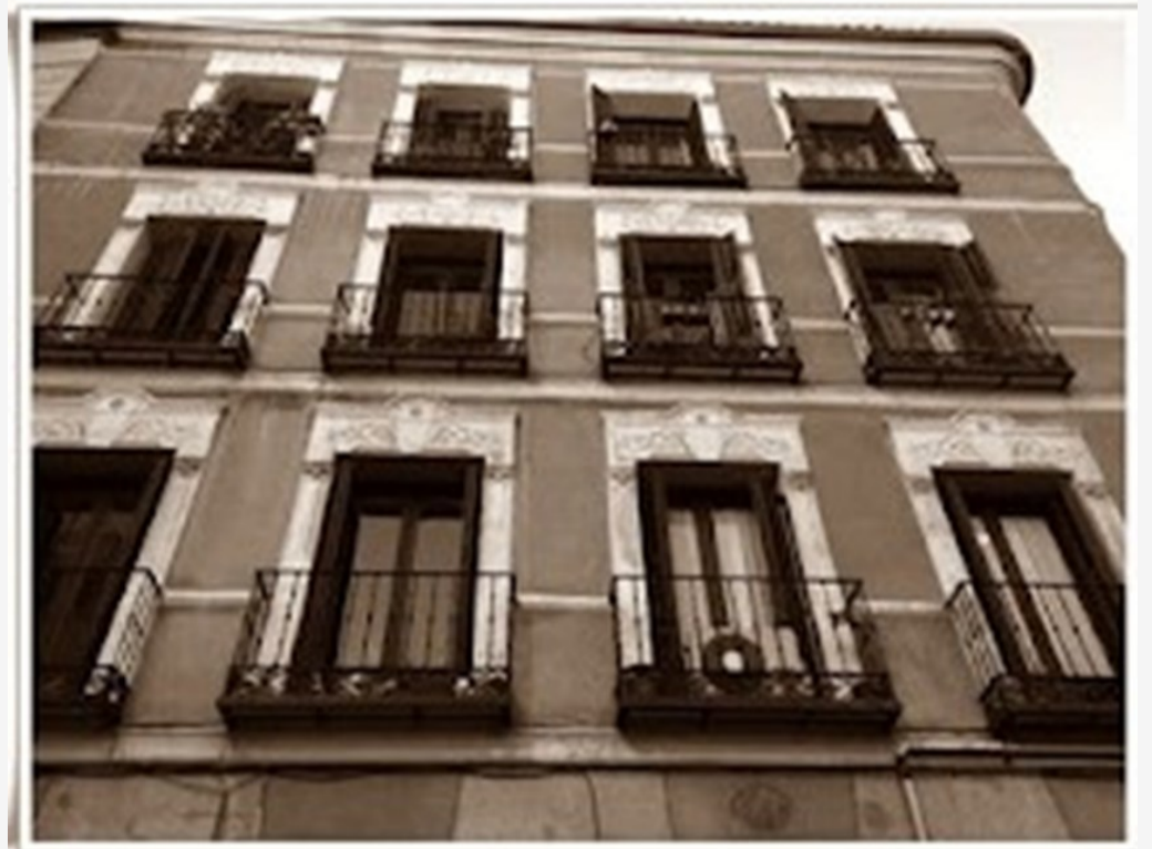
Detrás de estas ventanas ocurrieron la mayoría de los crímenes.
